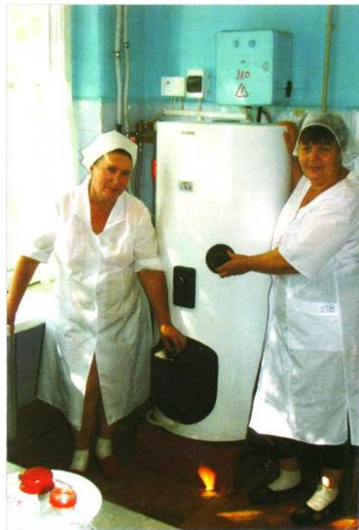
Работники детского сада №9 города Бахчисарая довольны гелиоустановкой, смонтированной при поддержке Бахчисарайского городского совета и фирмы «Крымская тепловая компания» в рамках выполняемого проекта.
